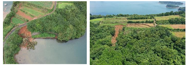
写真-2 表層崩壊の発生状況。
