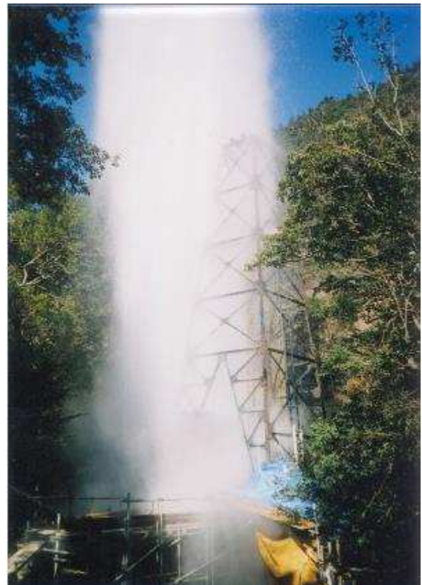
源泉替掘状況
