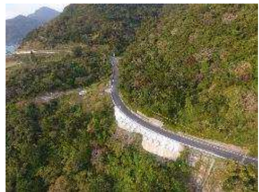
アンカー工設計箇所（黒瀬工区）
