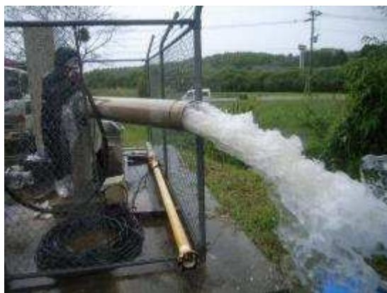
井戸洗浄状況（エアーリフト工）
