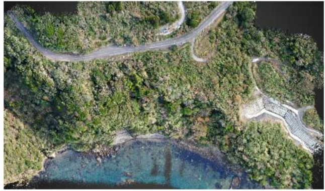
レーザ測量結果 (点群を着色することで視覚的な共有が可能となる)
