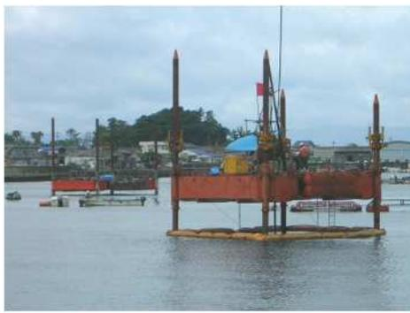
(左：鋼製槽（水深40m対応）；右：マット台船（水深30m対応）)
