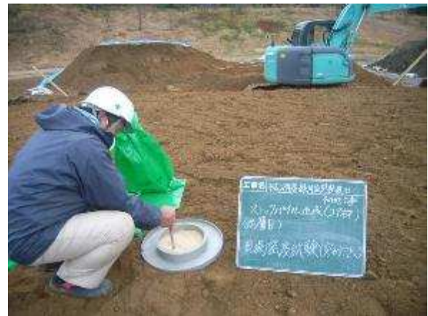
現場密度試験（突砂法）
