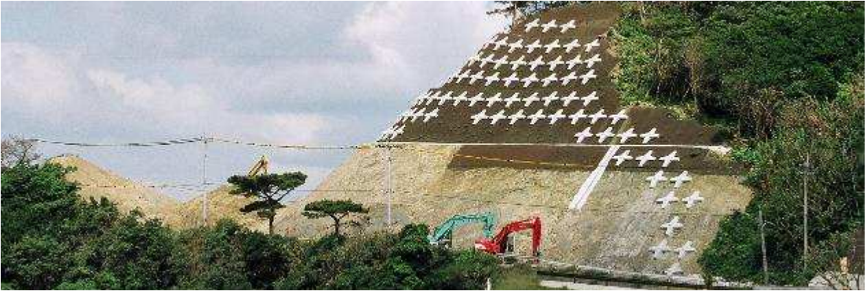
道路改築工事（屋鈍8工区）
