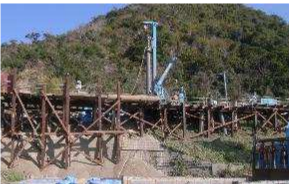
道路補修（災害防除）工事（後藤工区）
