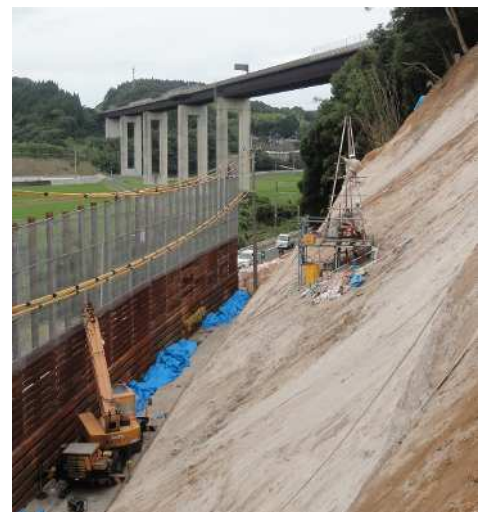
斜面災害でのボーリング
