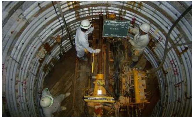
地すべり対策工事（中之島4工区）
