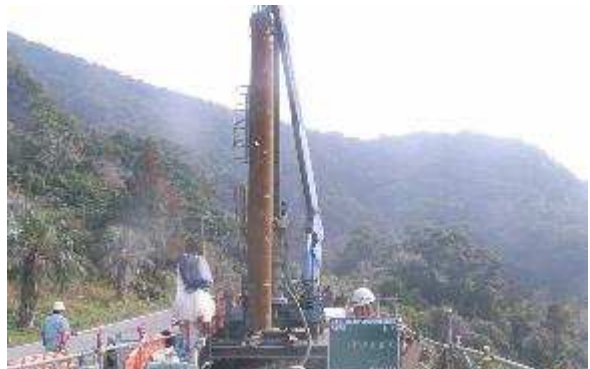
同左 作業状況
