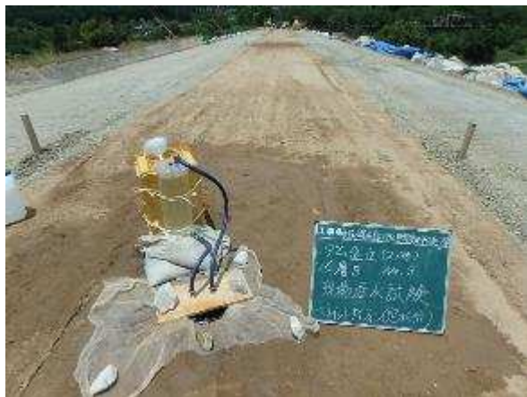
現場透水試験（マリョットサイフォン）
