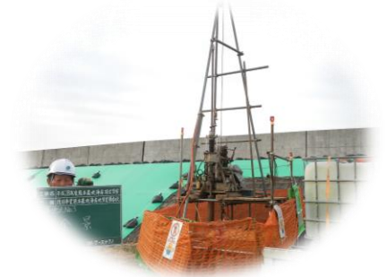
熊本地震災害復旧のため、ボーリング・土質試験を実施 (熊本市内)
