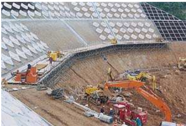
災害復旧のための水抜き工施工状況
