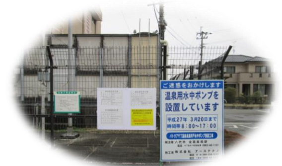
地下数百mに温泉水中ポンプ設置 (八代市内)
