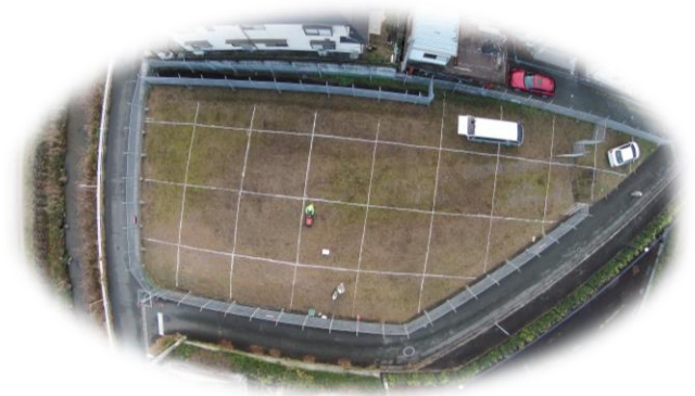
地中レーダー探査 (作業状況空撮写真)
