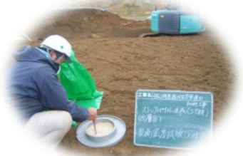
緑川ダムにおける品質管理試験
