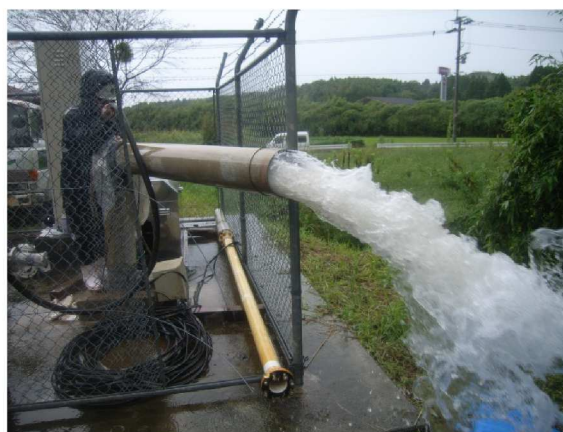
井戸洗浄状況（エアリフト工）
