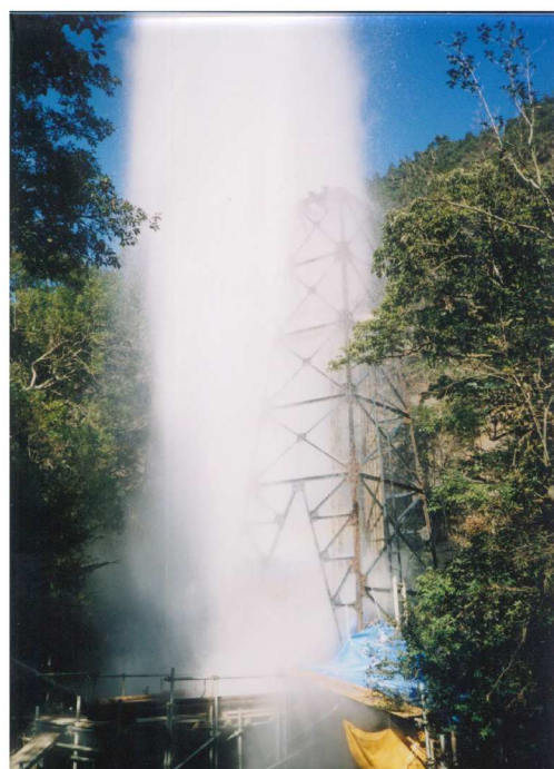
源泉替掘状況
