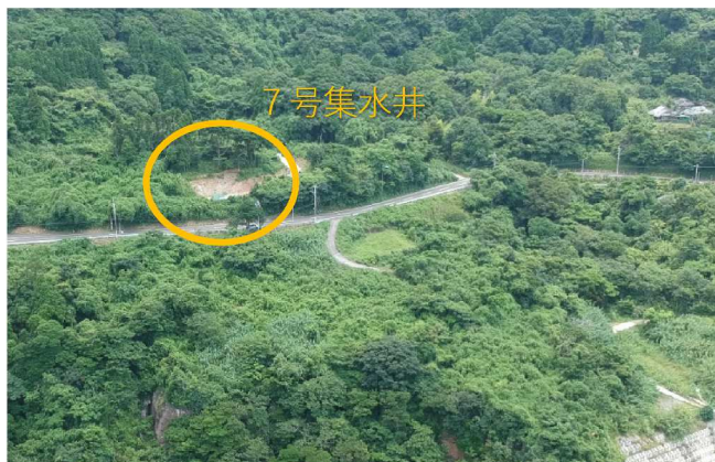
国道 226 号線と 7 号集水井
