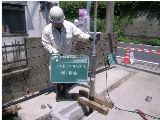
水資源開発（ポンプ挿入）状況
