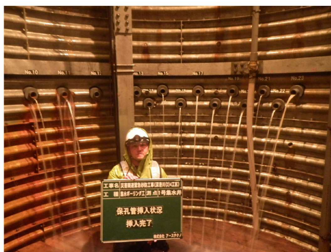
災害関連緊急砂防工事（深港川(2)4工区）（掘削深度 52.5m）
