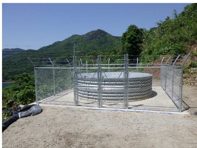
地すべり対策工事（平崎地区 R3-1 工区）7号集水井
