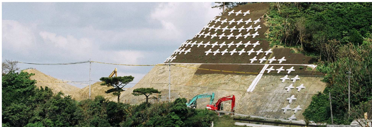
道路改築工事（屋鈍8工区）
