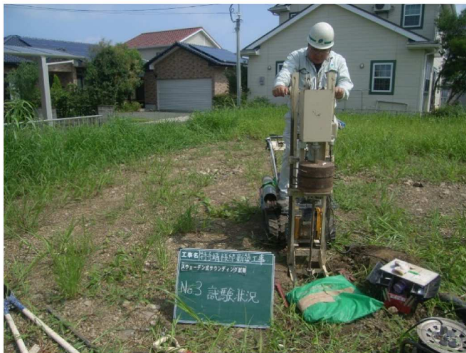
スウェーデン式サウンディングの実施状況 自走式のサウンディング機によって、狭いスペースでも効率的な機材搬入を行います。
