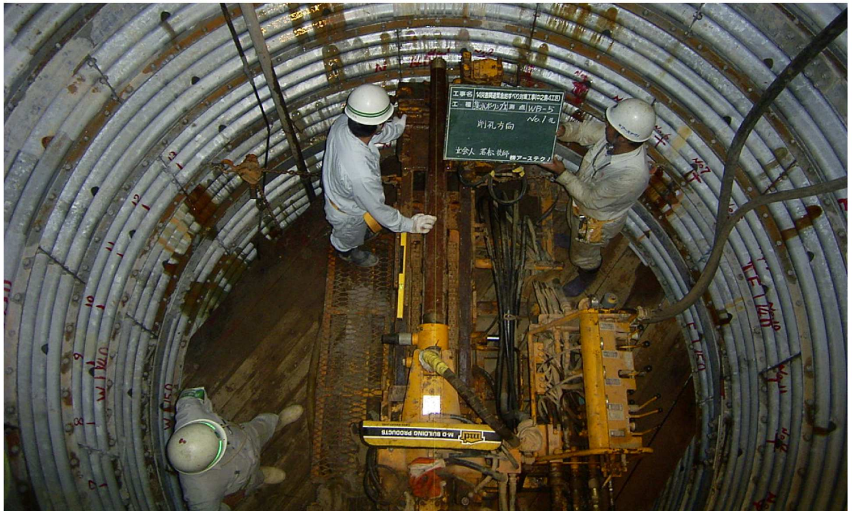
地すべり対策工事（中之島4工区）
