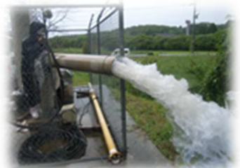
洗浄工 (エアリフト)
