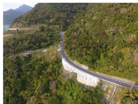
アンカー工設計箇所（黒瀬工区）
