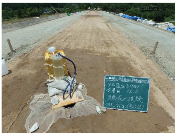
現場透水試験（マリ奥特サイフォン）
