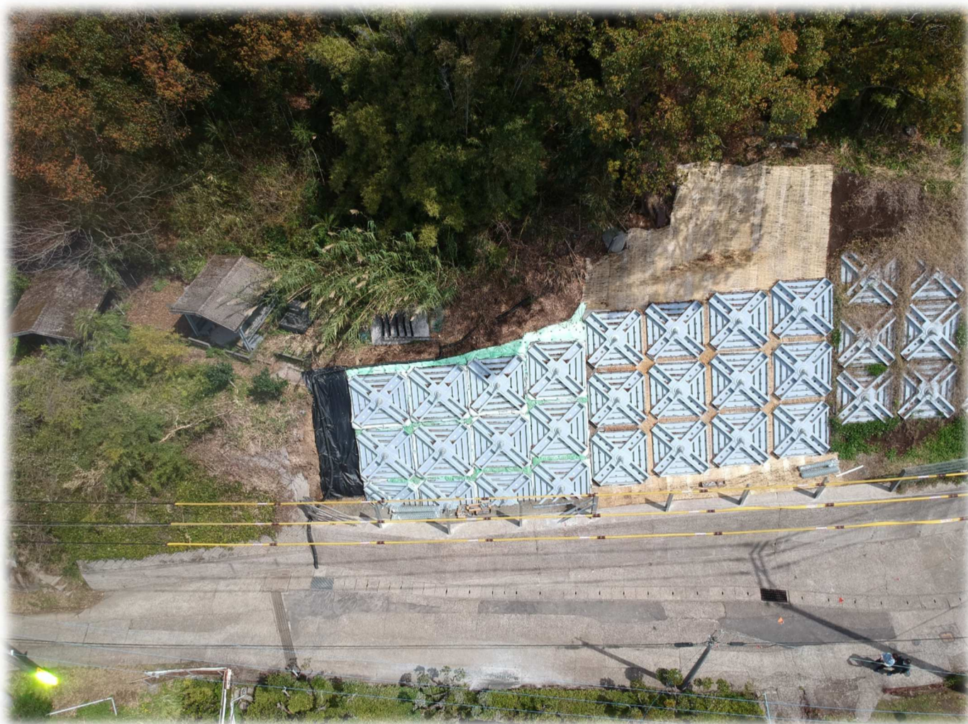
【アンカー工(軽量受圧板)施工事例】 (事業間連携砂防等(地すべり)工事(南園 R2-3 工区))(令和 3 年度)
