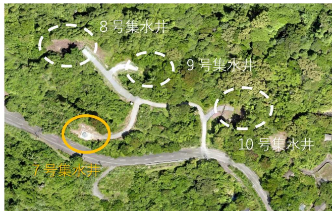
集水井ドローン空撮
