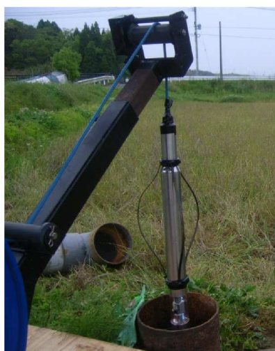
井戸孔内カメラ撮影（右が撮影写真）
